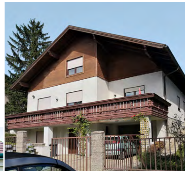
1140 Wien Ein- bis Zweifamilienhaus Grundstück
